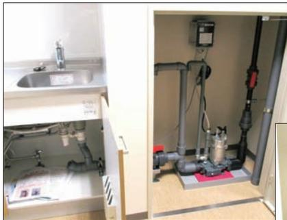
新築建物の地下にある従業員休憩室のシンク排水用途、シンク横のシャフト室にポンプを設置
