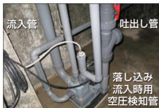
ポンプは地下ピット設置で器具より下階のため落とし込み流入時空圧検知配管としています
