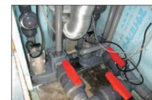
男女トイレ別にH-NA型ポンプを設置、万一の異常時バックアップ用にバイパス管付流入管となっています
